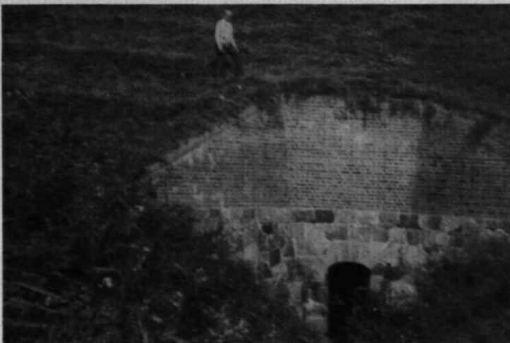
Das „Gewölbe“ bei Georgensdorf , von Landsmann Kortmann im Sommer 1984 wiederentdeckt und im Bilde festgehalten
